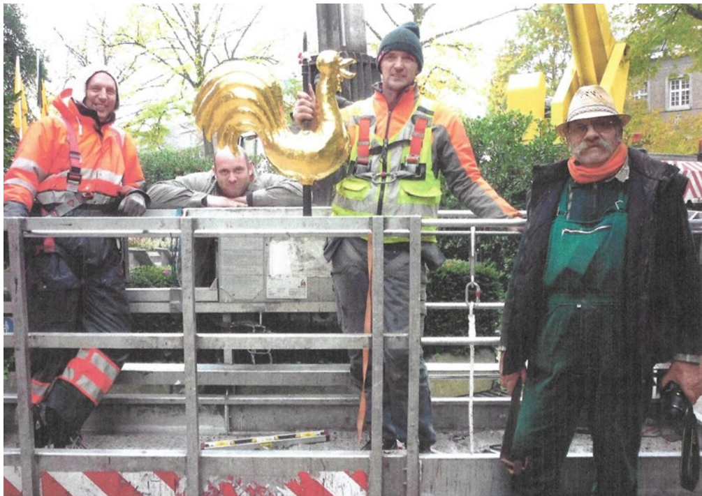
Plaatsen nieuwe haan op de kerktoren.
