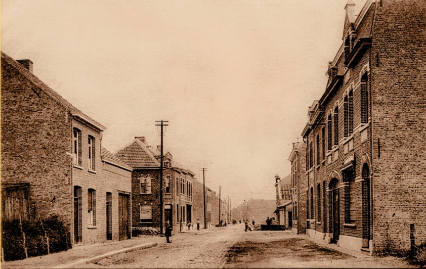
Palingstraat/Overwinningsstraat rond 1920, waar nog herstellingen bezig zijn van de oorlogsschade van WO I. Fotograaf onbekend.
